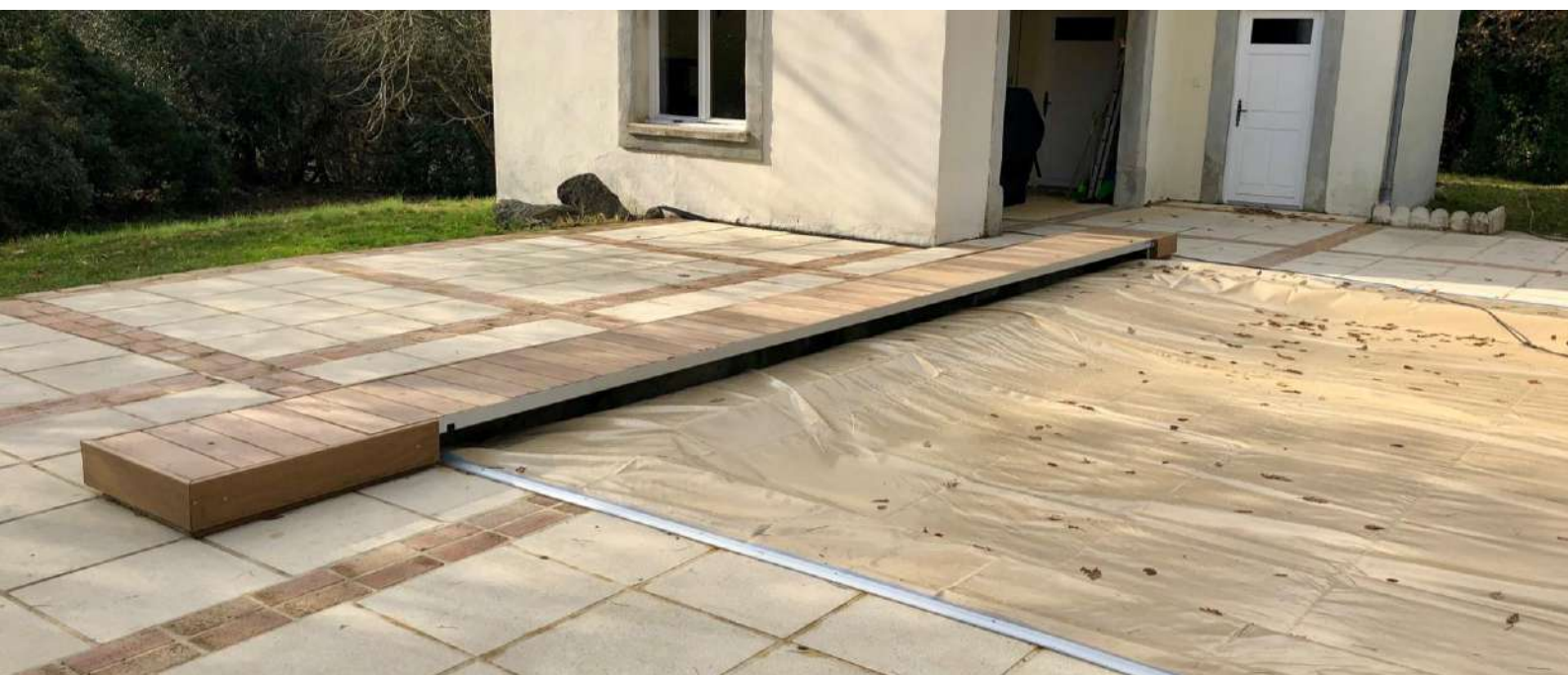
Couverture automatique intégrée avec rails sur margelles
