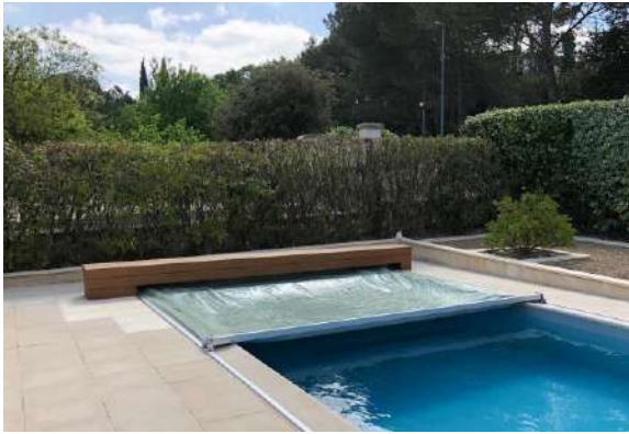
La couverture circule dans un rail fixé sur margelles
