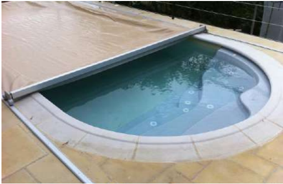
La couverture circule dans un rail fixé sur margelles
