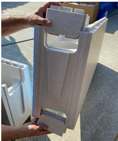
Mise en place des bouchons d'extrémité
