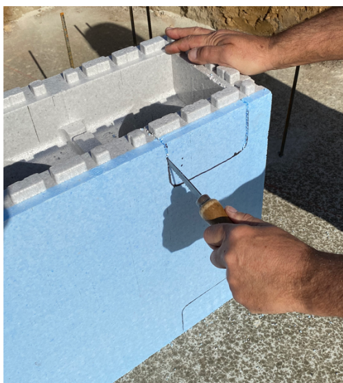
Découpe à l'aide d'un couteau à dents
