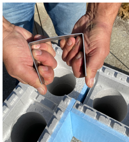
Cintrer légèrement les renforts d'angle métallique
