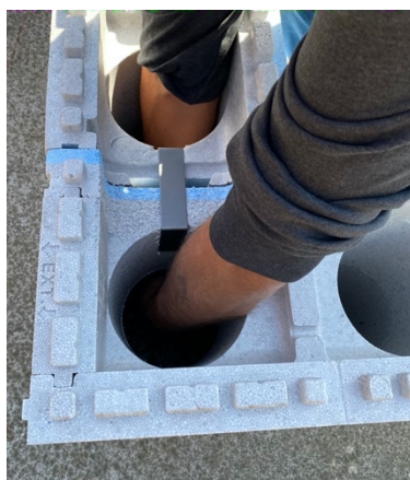
Enfoncer en force la pièce métallique de maintien des angles. Il y a une pièce sur le dessus et une pièce à mettre sur le dessous
