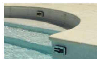
Ancrages de sécurité
