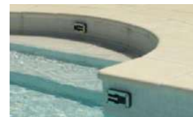
Ancrages de sécurité
