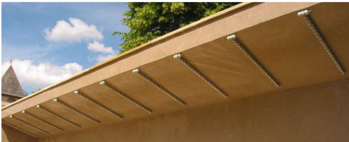
Attention, les roulettes doivent être en appuis sur les lames et pas sur les bouchons
