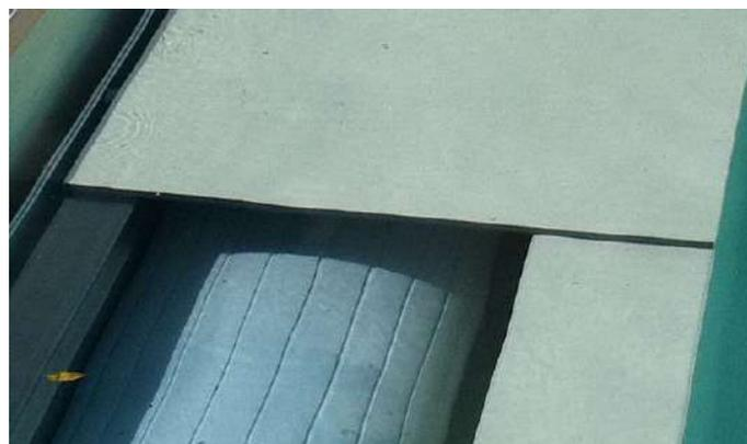
La membrane est encollée sur la plaque PVC préparée. Le champ avant (visible) sera habillé par un retour de membrane soudée sur le revers de la plaque. Les 3 autres côtés sont « champ libre » coupé net au cutter pour un bord à bord parfait.
