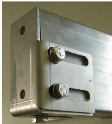
Largeur > 4m : mise en place de 4 supports inox contre la paroi latérale où viendra se positionner la structure en inox (photo droite)
