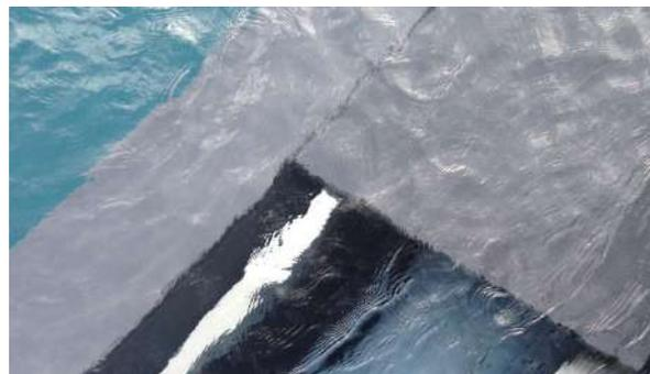
La membrane est encollée sur la plaque PVC préparée. Seul le dessus de la plaque est drappée. On coupe au cutter les 4 côtés pour un bord à bord parfait/
