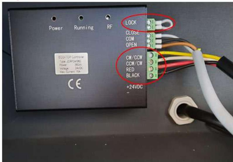
Connectez le câble alimenté en 24V (dans la salle technique) à la commande sur les bornes 24Vcc +/-.
