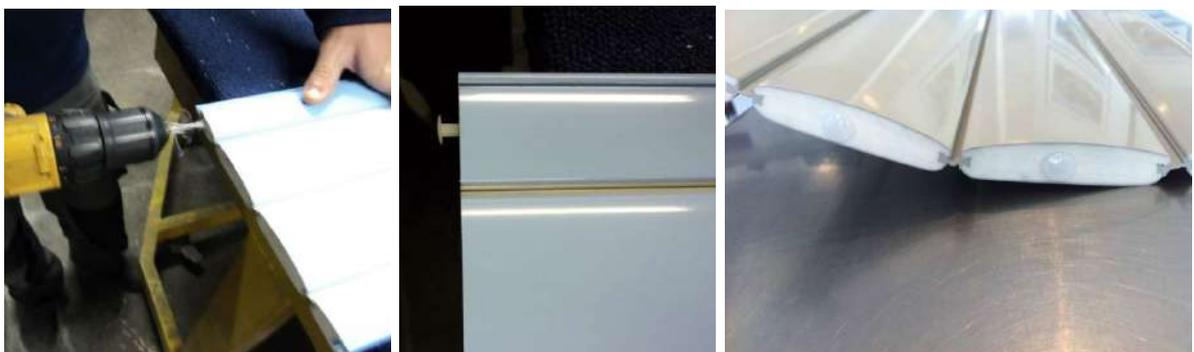
Assembler les lames sur l'eau. Pour le faciliter, vous pouvez utiliser un lubrifiant (Ex Vaseline). Il faut installer les lames correctement : la côté qui est légèrement arrondi en haut et le côté plat en bas.
