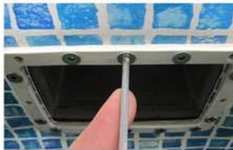
Introduire les flexibles pneumatiques à l'aide du fil de traction. Garder en réserve du flexible à gauche dans chaque logement, afin de pouvoir réparer en cas de panne. Assurez-vous de bien visser le pivot à l'arrière du boîtier.
