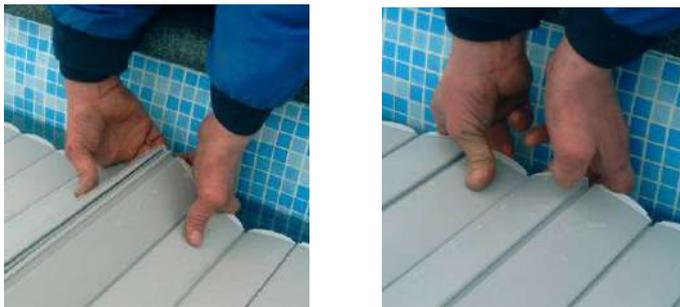
Maintenant, changer de côté (si possible), et procéder à des effets “charnière” répétés de manière à faire progresser l'ensemble des deux tabliers. Ce phénomène de pliage permet de rapprocher automatiquement les deux lames qui s'assemblent au fur et à mesure. Des mouvements amples permettent de créer des vagues dans la piscine qui sont propices à faciliter le clipsage.
