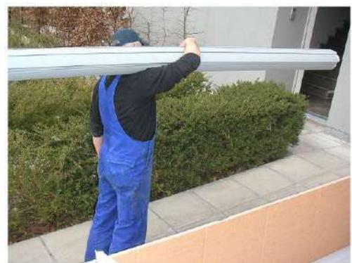
**Orientation des lames** : le dessus de la lame est légèrement incurvé, le dessous est plat. La partie ouverte de la lame est orientée vers le bout du bassin, la partie mâle est orientée vers l'axe.
