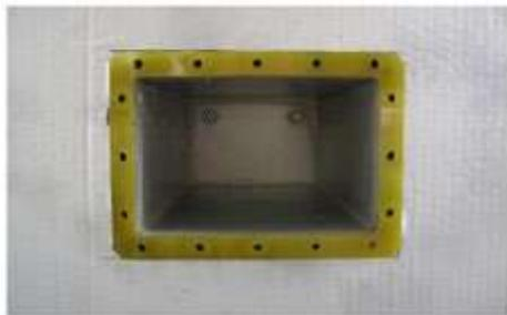
**EXTRA (Avec liner)** Faire la découpe du liner au niveau de la pièce à sceller de la dimension de l'ouverture (interne). Visser la bride d'étanchéité avec le liner et le joint autocollant pour rendre le bassin étanche. Faire attention à l'orientation de la bride d'étanchéité.
